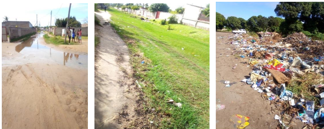
Figura 3: Problemas ambientais que ocorrem no bairro Machava Bunhiça. Ruas alagadas, Erosão e capim na estrada.
