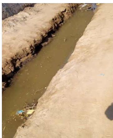
Figura 13: passagem da água pela vala abertura pelos munícipes.
